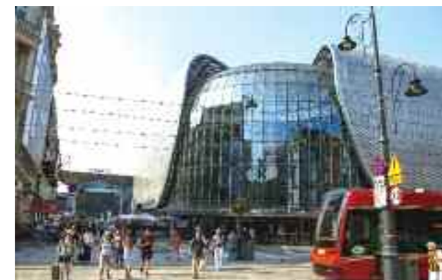
Galeria Katowicka stała się integralną częścią wyremontowanego Dworca PKP
